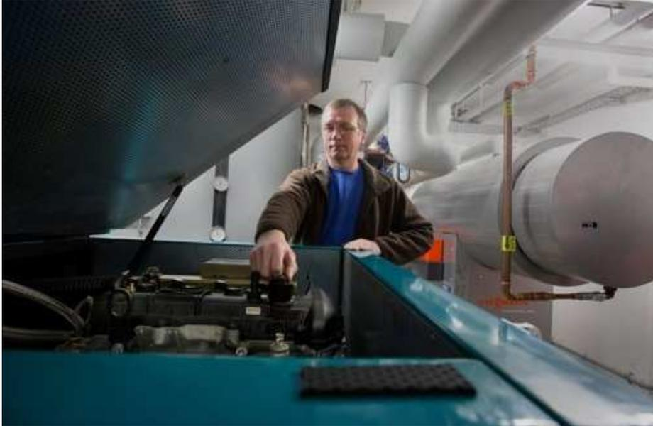
Gut gedämmte Kraftquelle mit vier Zylindern im Keller: Hausmeister Frank Helmer überprüft ein Blockheizkraftwerk in einem Haus der Stuttgarter Baugenossenschaft Friedenau. Foto: Michael Steinert
